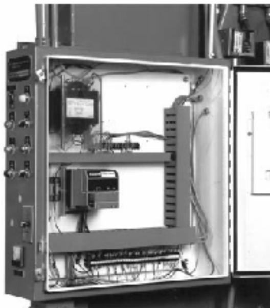
Рис. 7. Монтаж на электрической панели.
